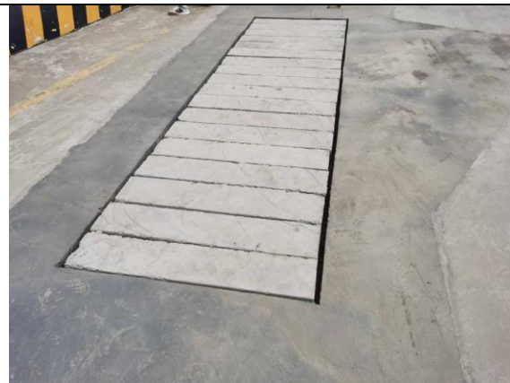
初期雨水池照片
