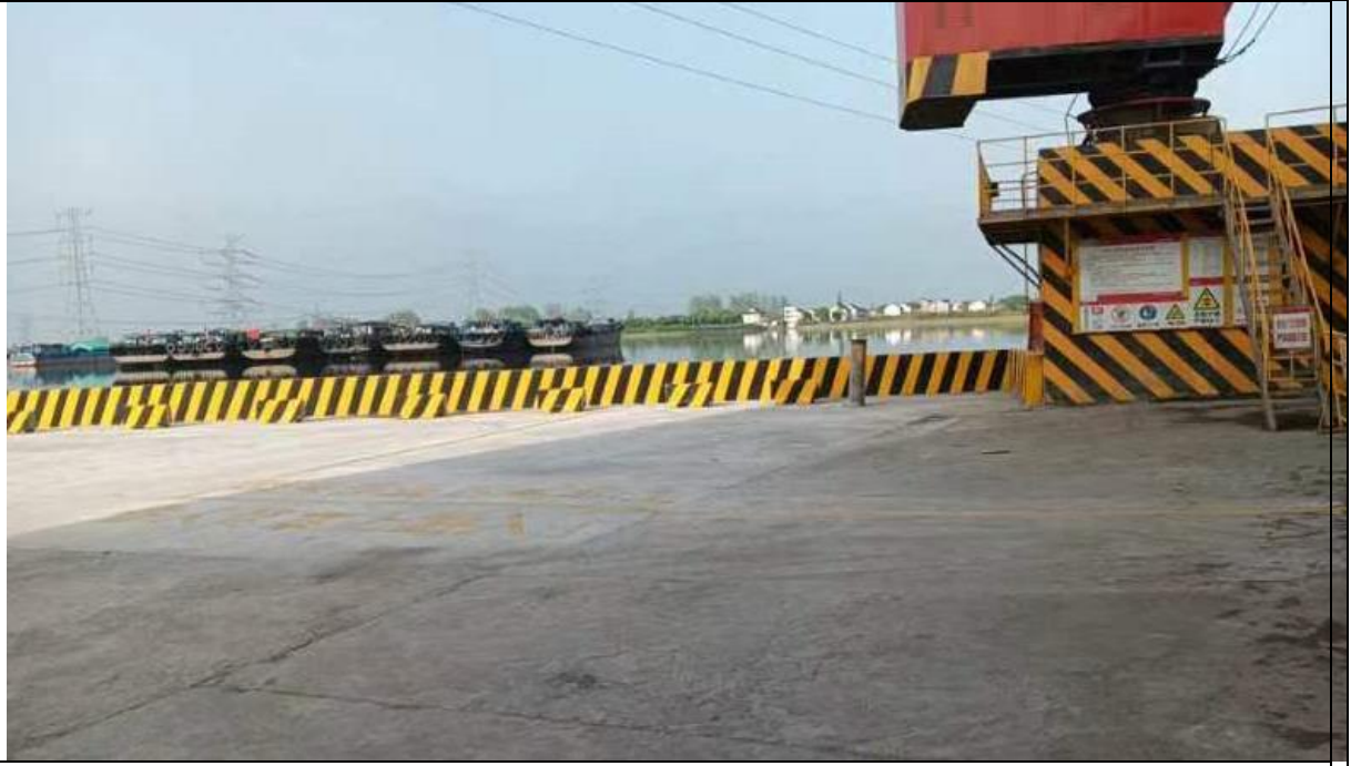
码头前沿围挡（堰）照片
