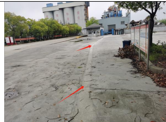
新建排水管网照片
